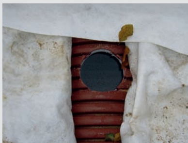
Forslag til/eksempel på forstærkning af siderne med plastarmeringsnet EXPO 1211 Std.
