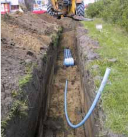
Udlægning af rør og advarselsnet
